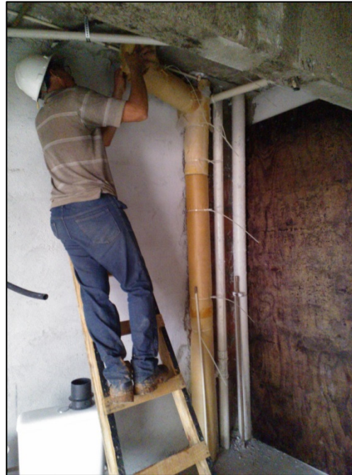
Envelopamento de tubulações hidrossanitárias
