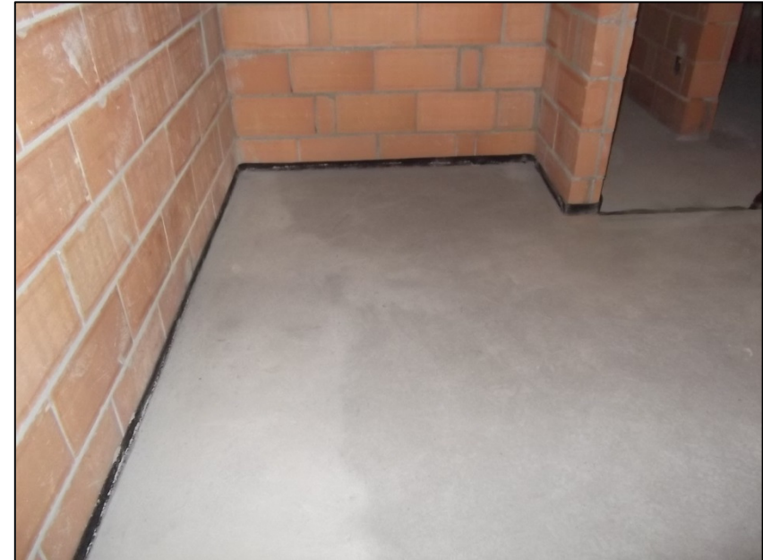
Contrapiso flutuante com manta de borracha
