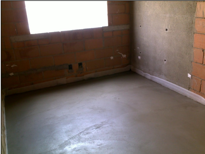
Contrapiso flutuante com manta de polietileno expandido
