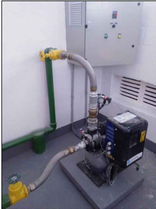
Base de inércia e conexões flexíveis para bombas de pressurização
