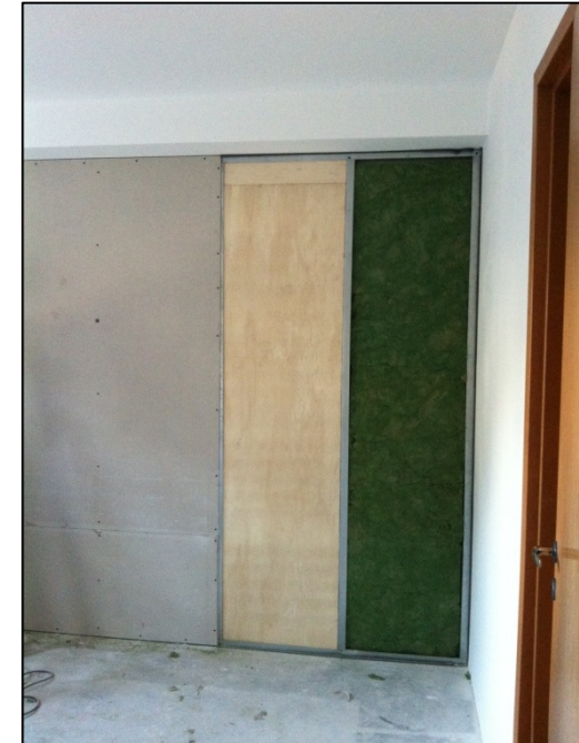
Parede falsa em drywall para melhora do desempenho acústico (só para emergências)
