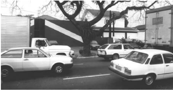
Figura 1: A solução de uma fachada cega em alvenaria, de frente para uma via ruidosa, foi adotada inicialmente para a casa adaptada como edifício comercial, à esquerda, providenciando-se a ventilação pelos fundos. O vizinho do sobrado branco, constatou o resultado e fez algo parecido. Com custos bem menores do que os do envidraçamento acústico, além da proteção contra o ruído, tiveram o ganho promocional, dando destaque às suas fachadas.
