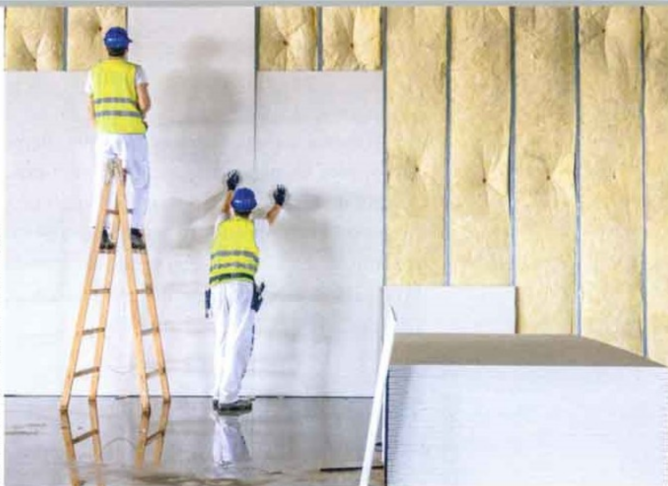
Paredes de drywall preenchidas com lã mineral
