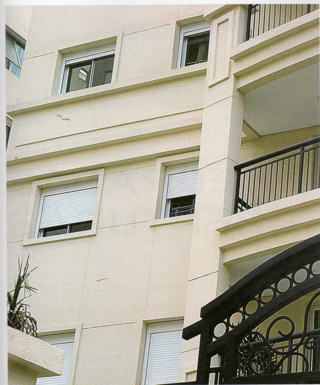
ENTRE AS TIPOLOGIAS ENSAIADAS, A JANELA DE CORRER INTEGRADA FOI A QUE TEVE MELHOR DESEMPENHO
