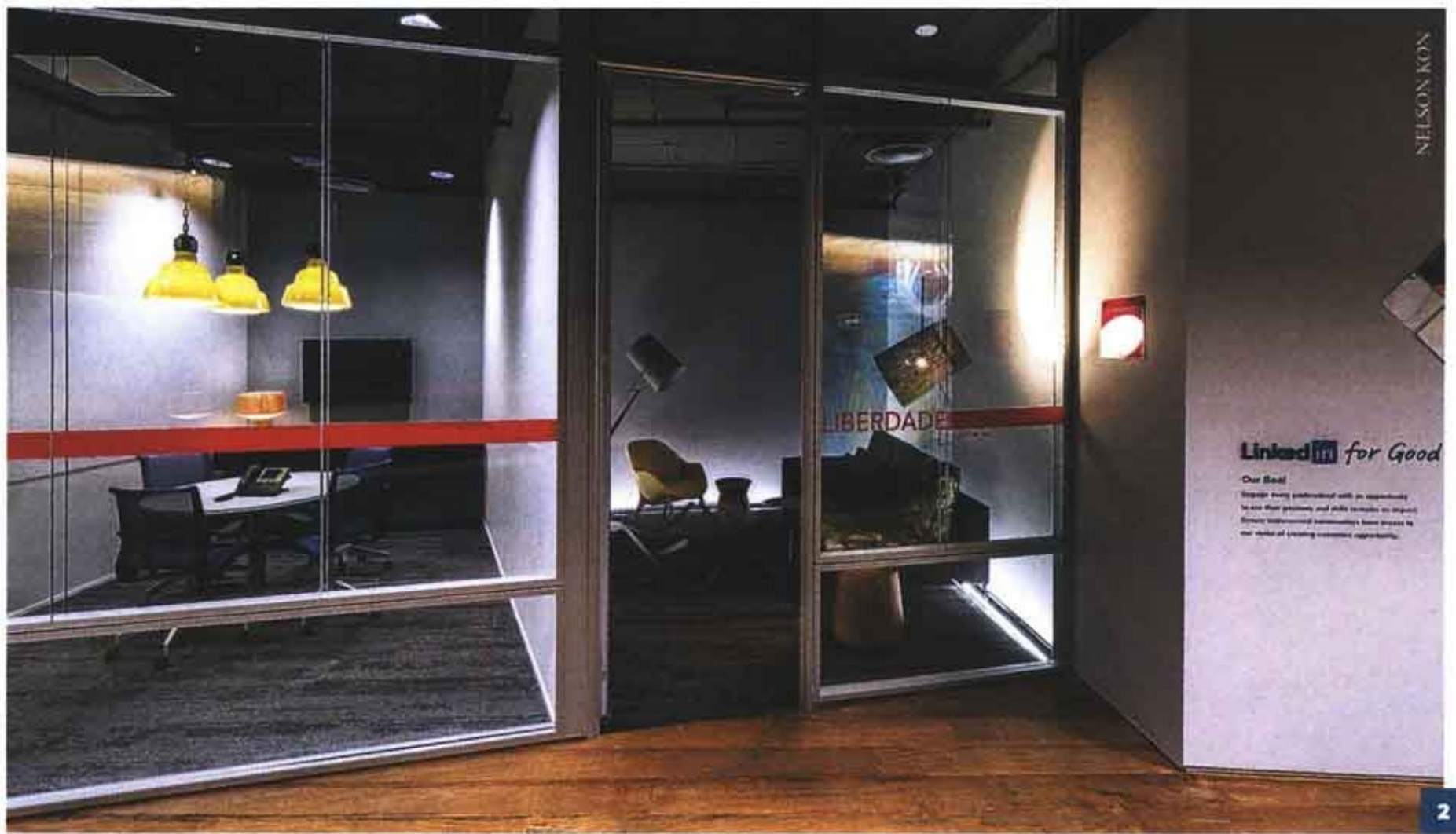
1 e 2 Com laje aberta, o escritório do LinkedIn recebeu painéis acústicos para absorver o som e atenuar ruídos. O projeto utilizou ainda drywall com lã de rocha entre as chapas para dividir salas privativas
