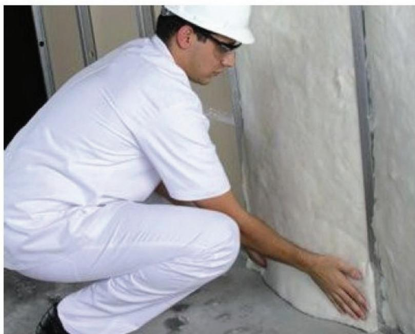
Segundo manual da Associação Drywall, uma parede com 9,5 cm de espessura tem poder de isolamento de 38 dB. Com a lã absorvente, o desempenho chega a 46 dB
